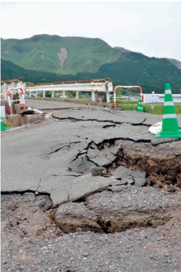
地割れ、陥没している道路 (阿蘇市)
