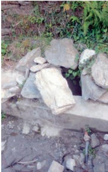
破損し、水漏れする水タンクとパイプ
