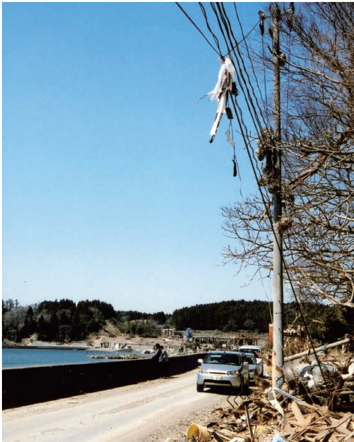
資材等が電線に巻き付いていた。津波の高さを知ることができる（陸前高田市） 撮影／岸野
